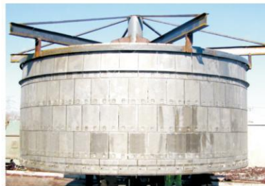
Preheater scraper Ducto de inmersión
